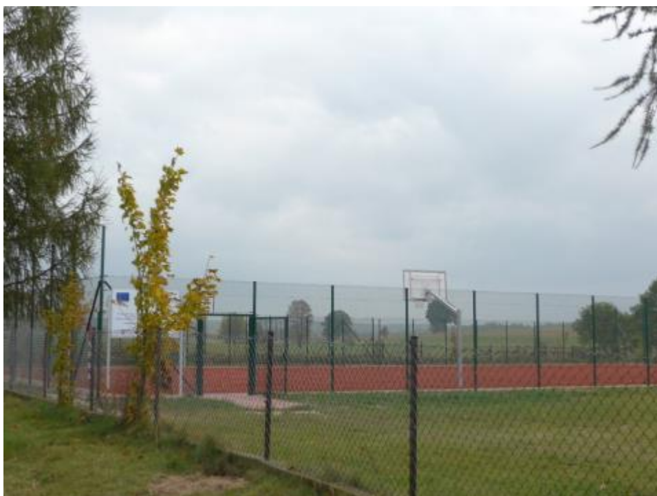
Zdjęcie 77. Boisko wielofunkcyjne w Wilczkowicach Fot. GRACZKOWSKI DOTACJE Sp. z o.o., październik 2015r.
