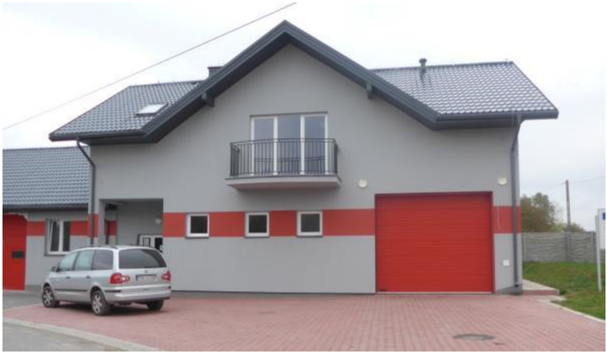
Zdjęcie 22: Budynek OSP w Jakimowicach Fot. GRACZKOWSKI DOTACJE Sp. z o.o., październik 2015r.
