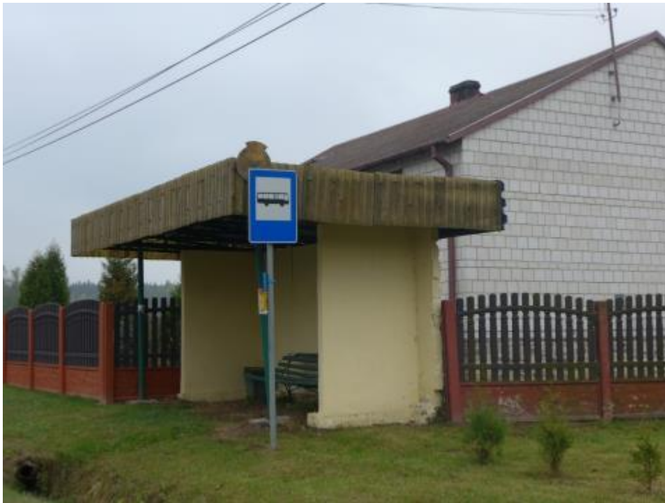
Zdjęcie 38. Przystanek w miejscowości Mularzów Fot. GRACZKOWSKI DOTACJE Sp. z o.o., październik 2015r.
