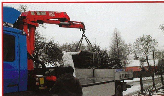
Ładowanie materiałów zawierających azbest.
