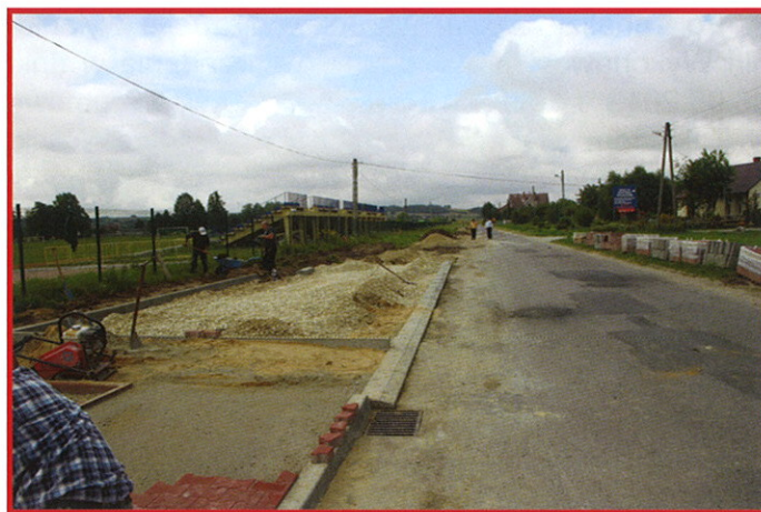
Roboty budowlane parkingu przy Stadionie
