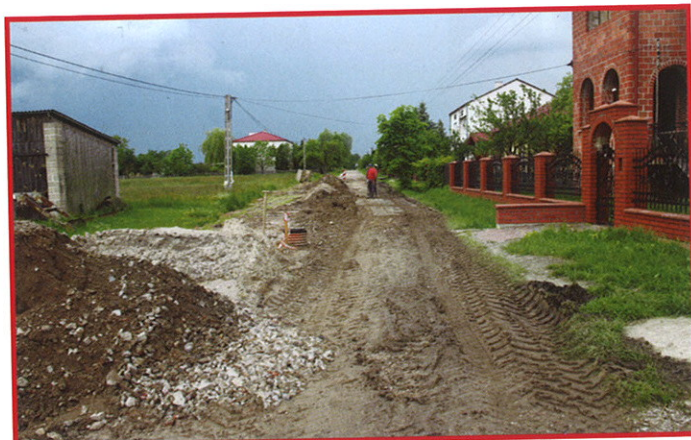
Budowa kanalizacji sanitarnej w Grodzisku
