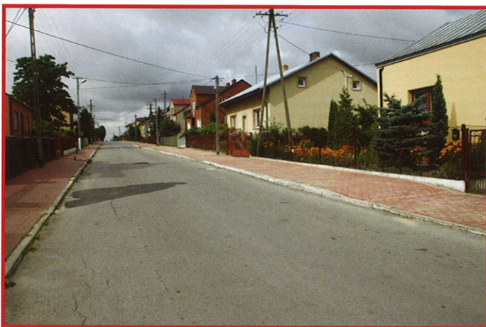
Budowa chodnika przy ulicy Żeromskiego
