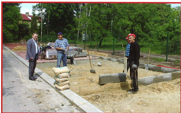
Roboty budowlane parkingu przy SPZOZ
