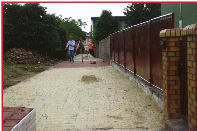
Nowa nawierzchnia ulicy Krochmalnej
